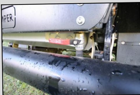
Cette vanne quart de tour sert à vidanger le réservoir de 30 litres qui recueille les eaux grises.
